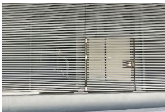
⑩-1 東側水栓・電源箇所
